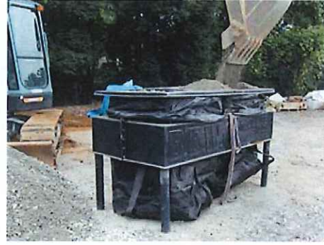
中詰め材の投入
