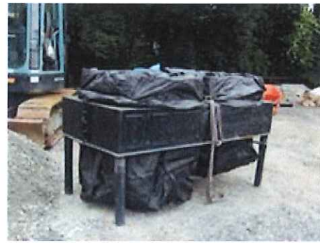
耐候性大型土のうのセット
