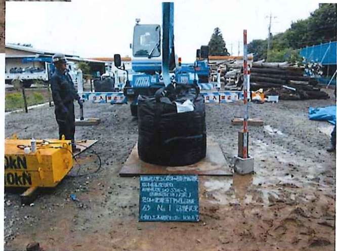
試験状況 記録写真(砂質土:試験体No.1)
